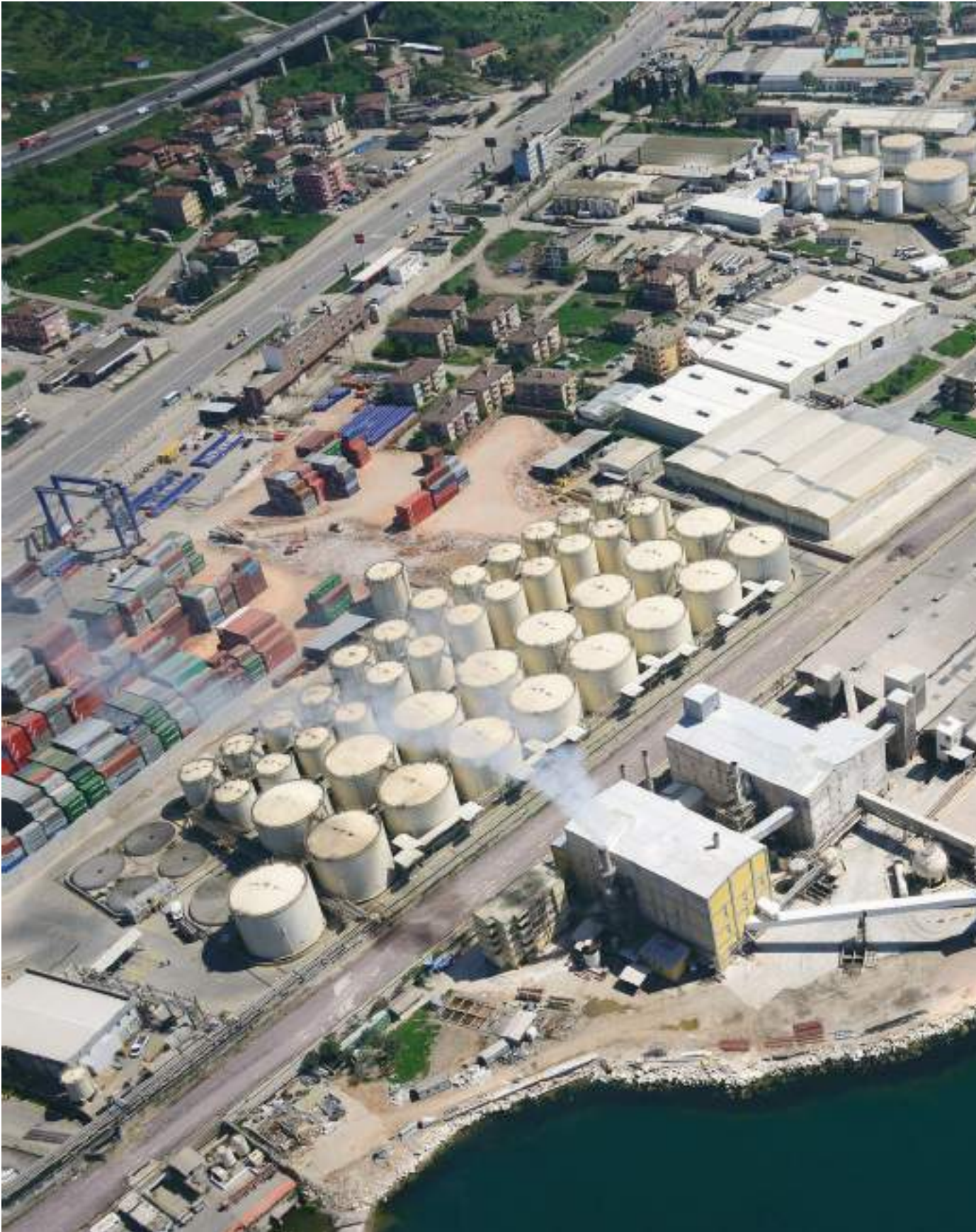
GÜBRETAŞ YARIMCA FACILITIES (KOCAELİ)
